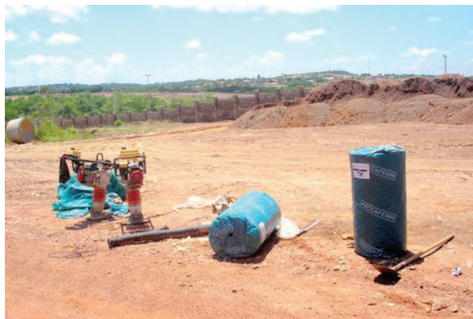
Durante a obra
