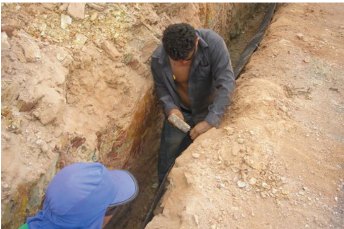
Durante a obra
