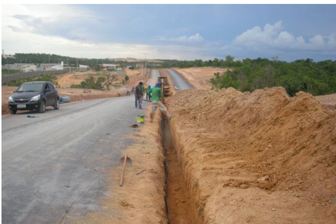
Durante a obra
