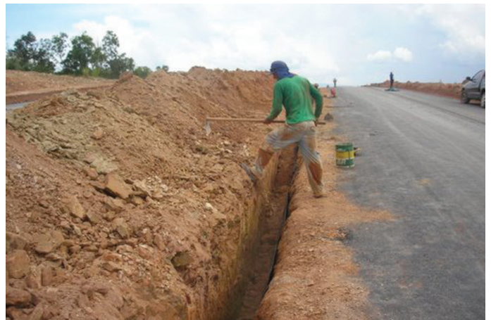
Durante a obra
