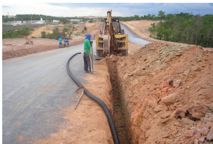
Durante a obra
