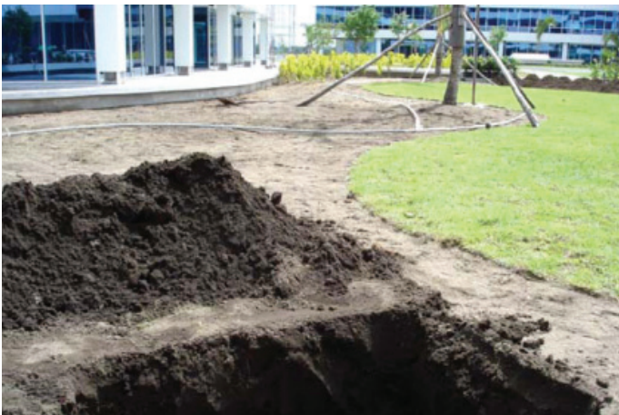
Durante a obra
