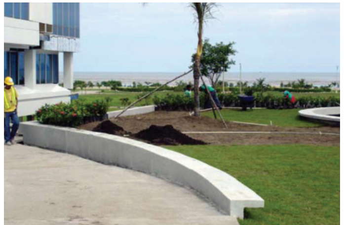
Durante a obra
